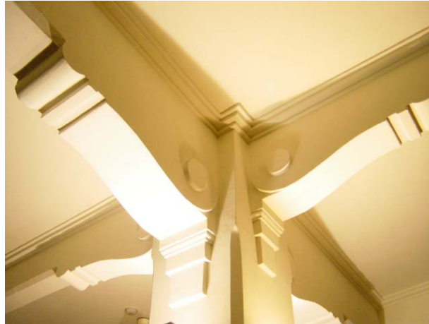
圣殿里屋顶圆柱和横梁的衔接设计
